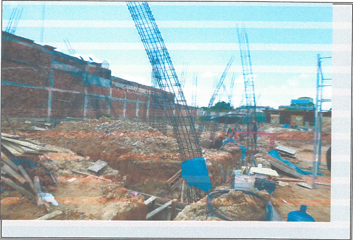
VISTA DE ENCOFRADOS DE VIGAS DE CIMENTACION EN MODULO E
