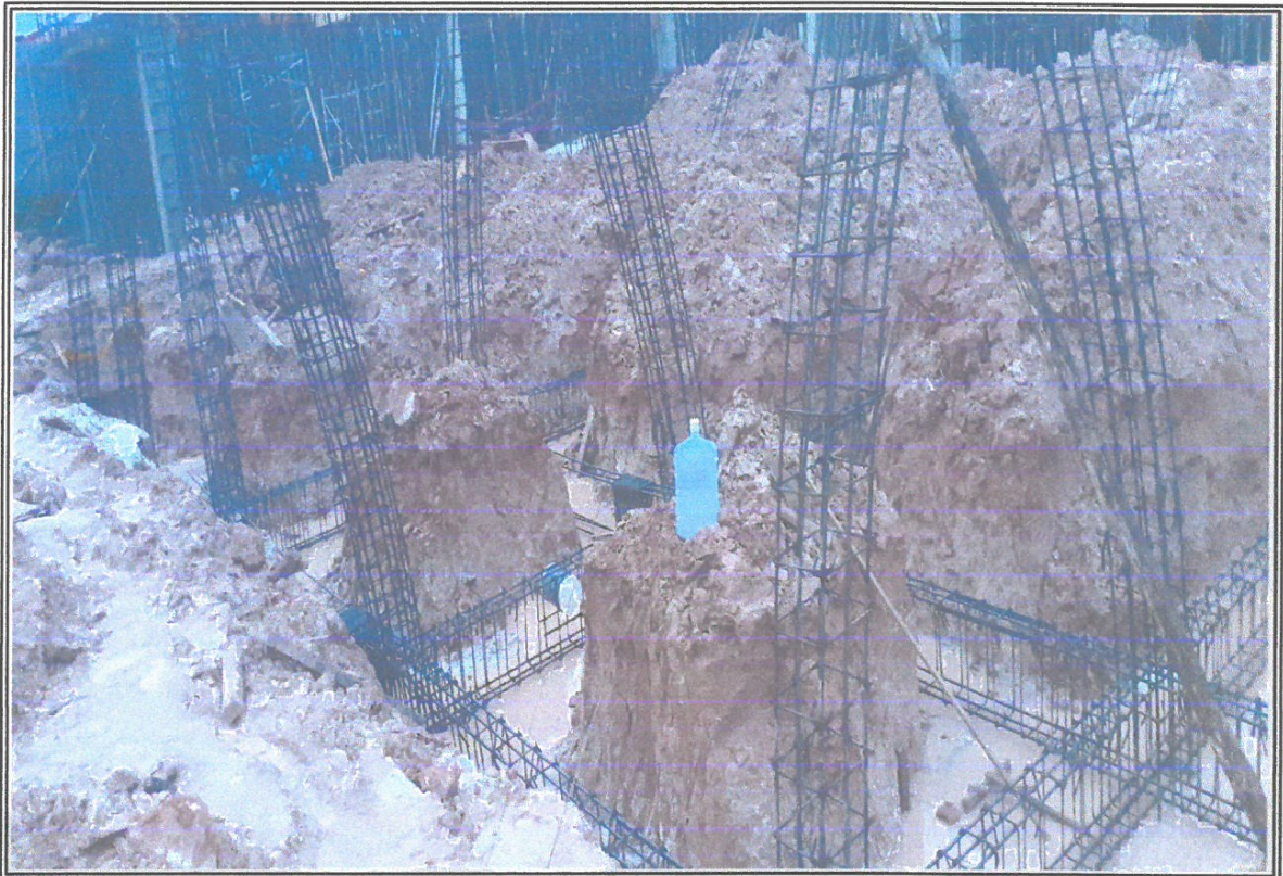
VISTA DE COLOCACION DE ACERO EN COLUMNAS Y VIGAS DE CIMENTACION
