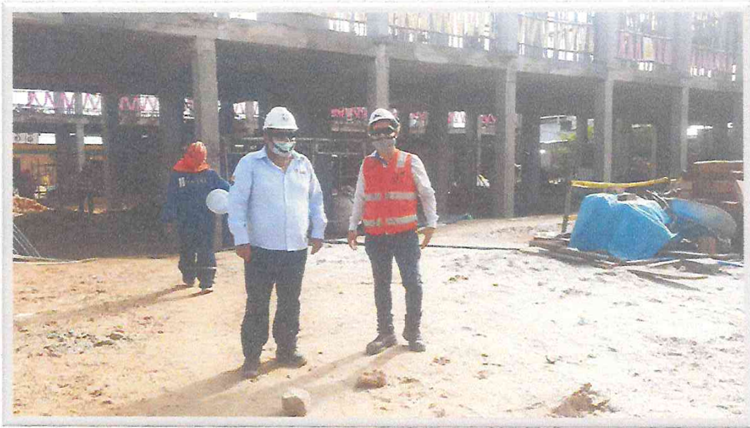
VISTA DE ING RESIDENTE Y SUPERVISION EN CAMPO.
