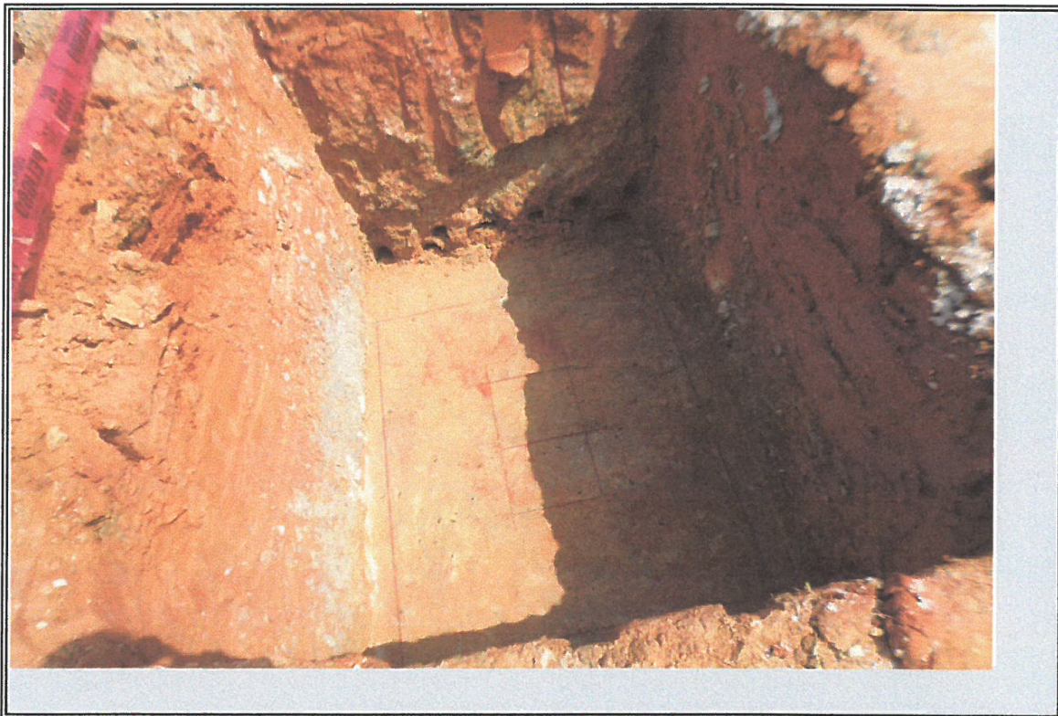
VISTA DE ZAPATAS TRAZADA DE BLOQUE C
