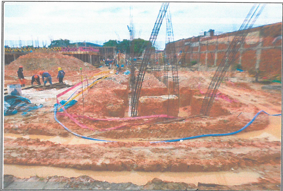
VACEADO DE MORTERO DE ZAPATAS Y VIGA DE COMENTACION EN EL BLOQUE F
