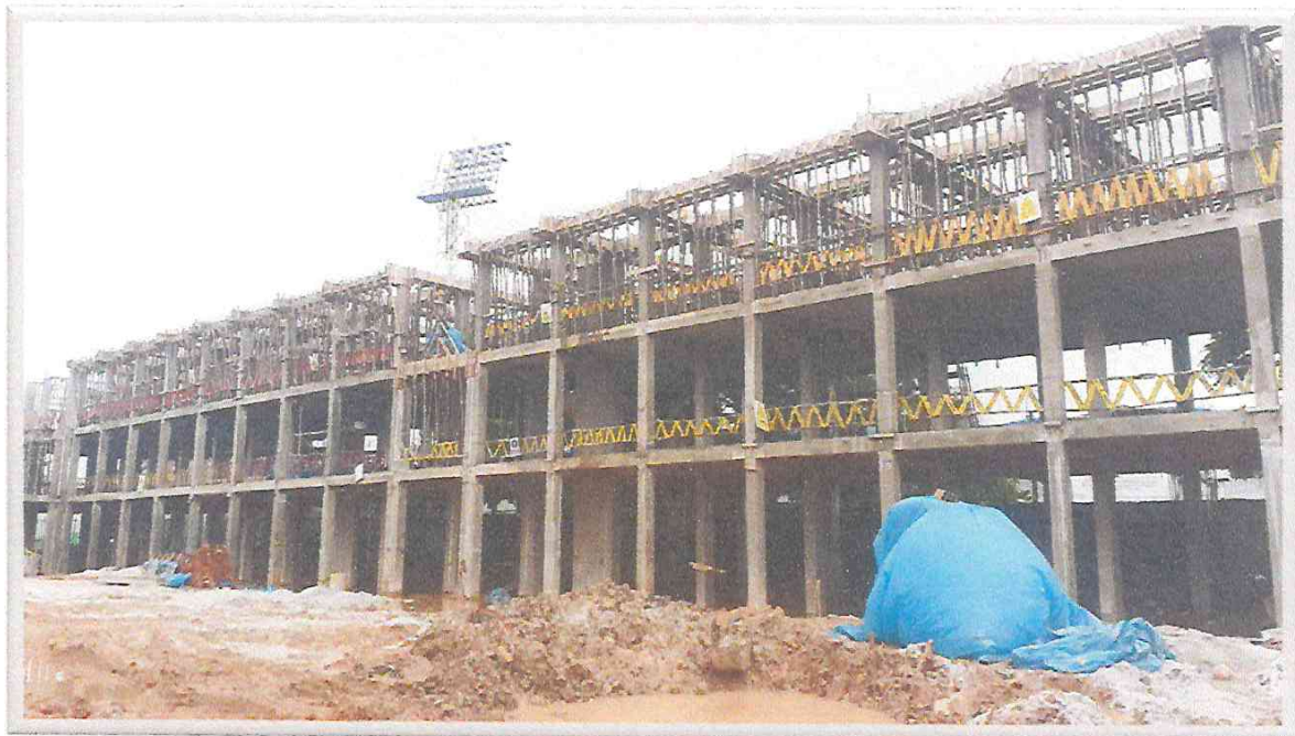
VISTA DE TRABAJOS DE ENCOFRADO DE MADERA DE VIGAS DE 3° PISO DE MOD "B"
