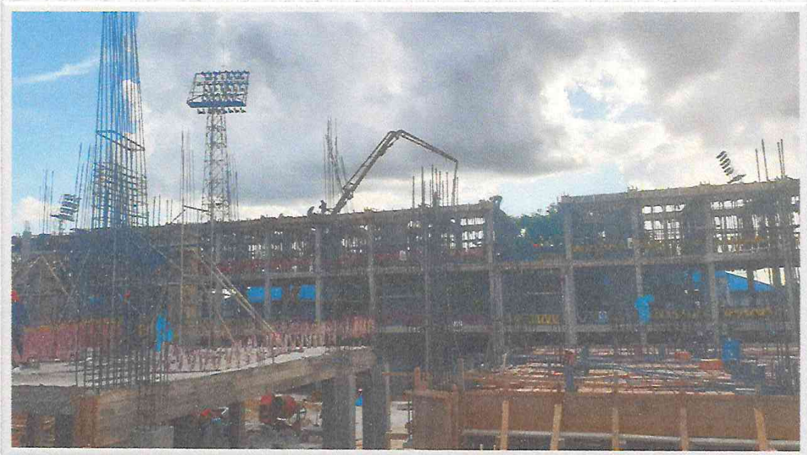
VISTA DE VACIADO DE MORTERO CON MIXER DE VIGAS DE MORTERO ARMADO EN 3°PISO DE MOD "B"
