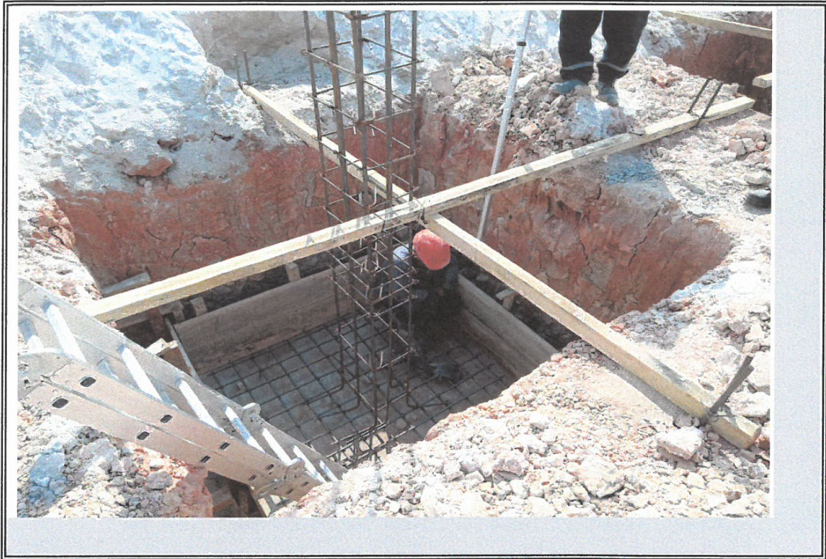
VISTA DE ENCOFRADO DE MADERA PARA ZAPATA DE MODULO C
