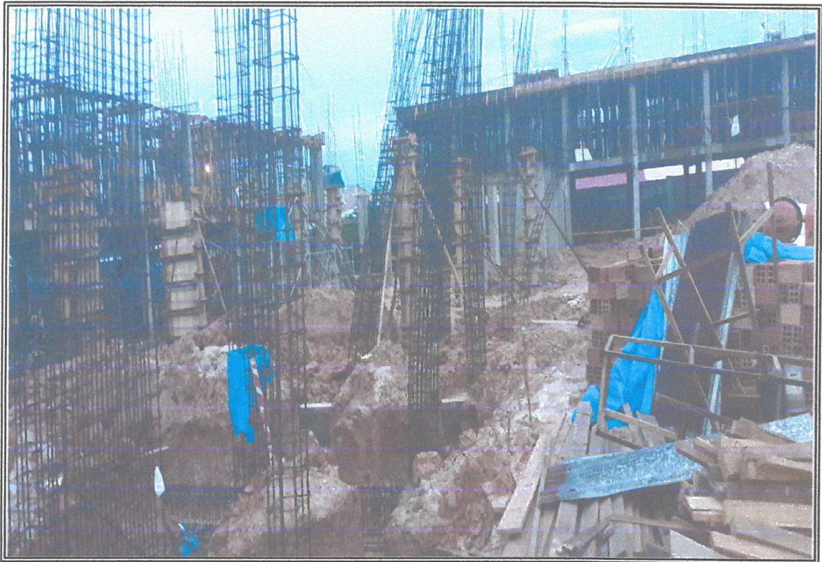
VISTA DE VACEADO DE VIGAS DE CIMENTACION EN EL MODULO C
