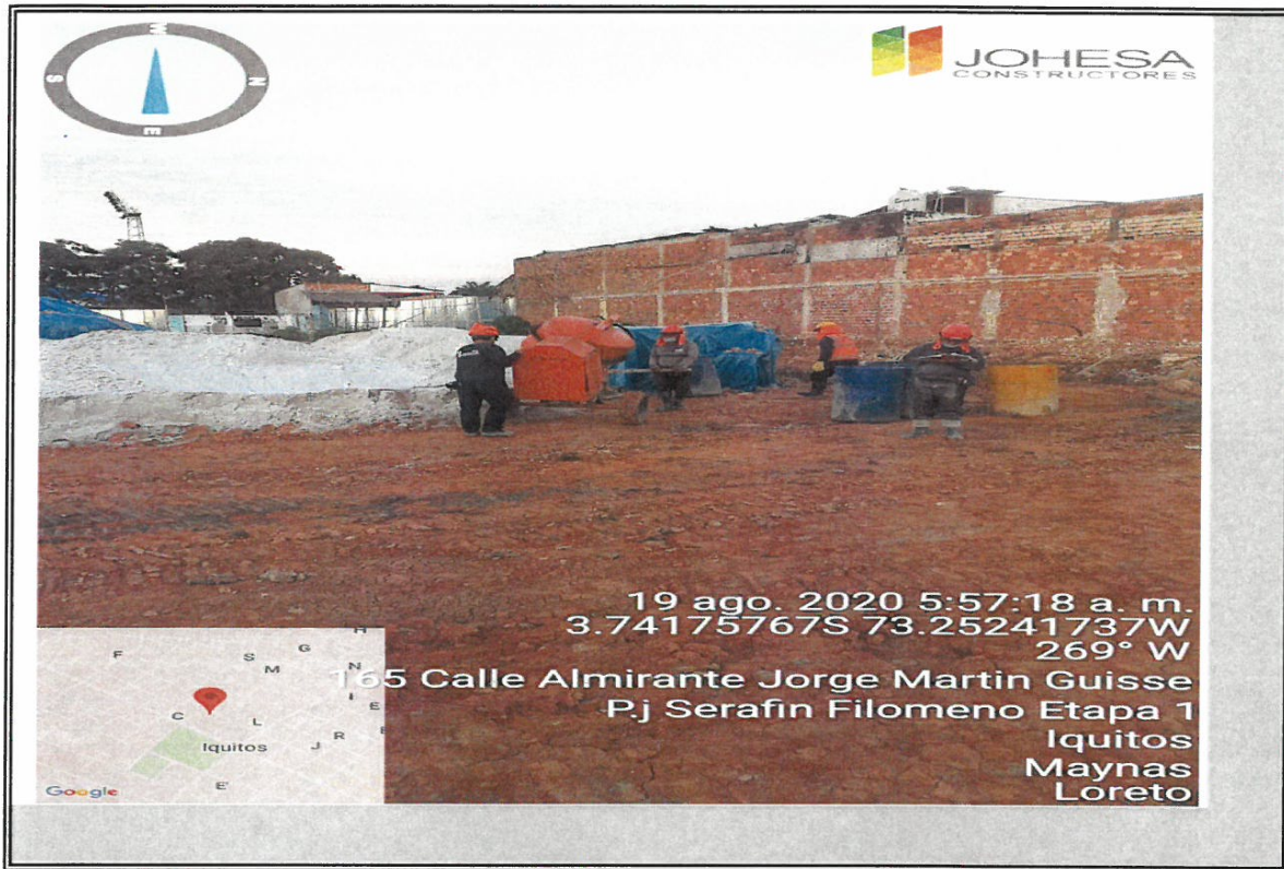
VISTA DE VACIADO DE MORTERO EN TANQUE CISTERNA
