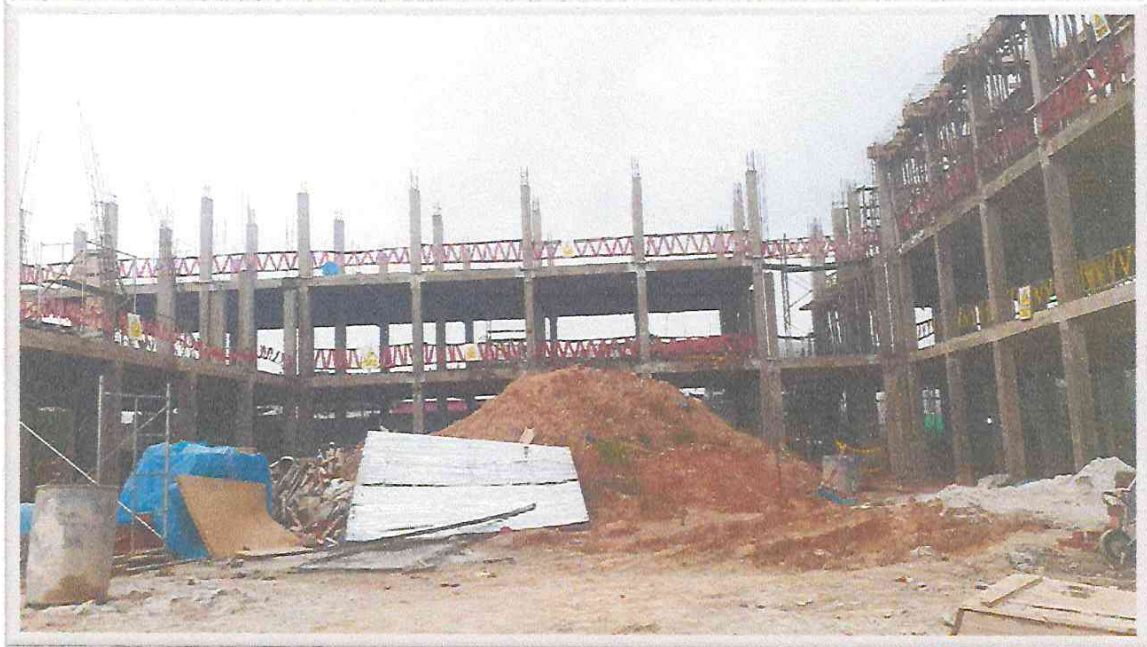
VISTA DE COLUMNAS DE MORTERO ARMADO DE 3° PISO DE MOD "A"
