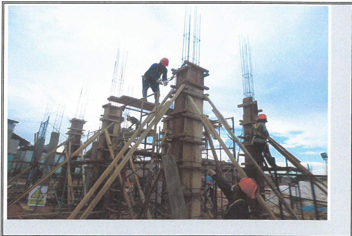
VISTA DE ENCOFRADO DE MADERA DE COLUMNAS DE BLOQUE B
