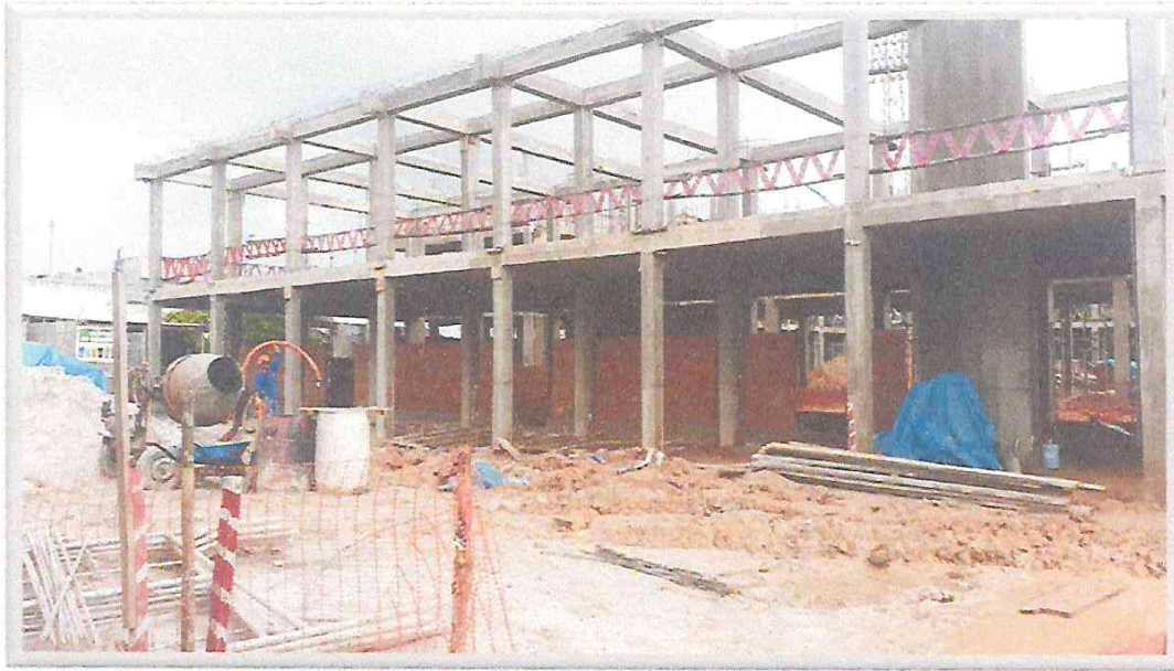
VISTA DE TRABAJOS DE ALBAÑILERIA EN 1° PISO DE MOD "D".
