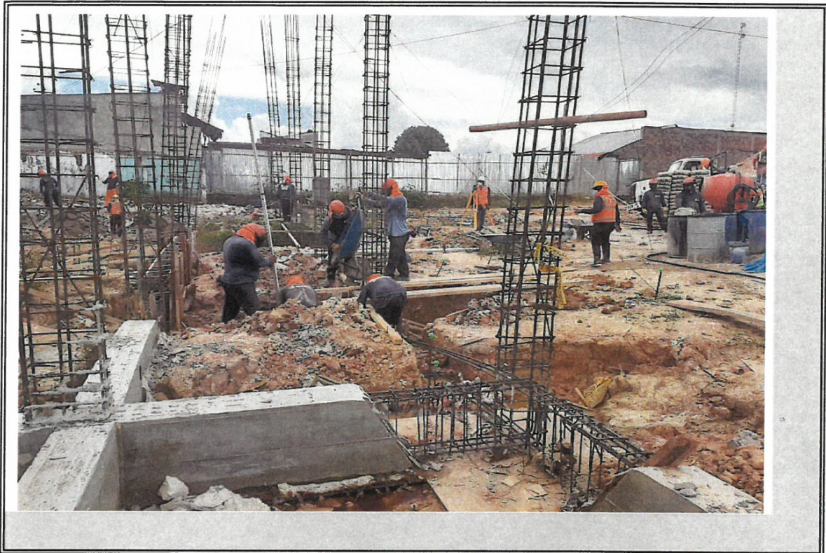
VISTA DE VACIADO DE MORTERO DE ZAPATAS DE MODULO "B"
