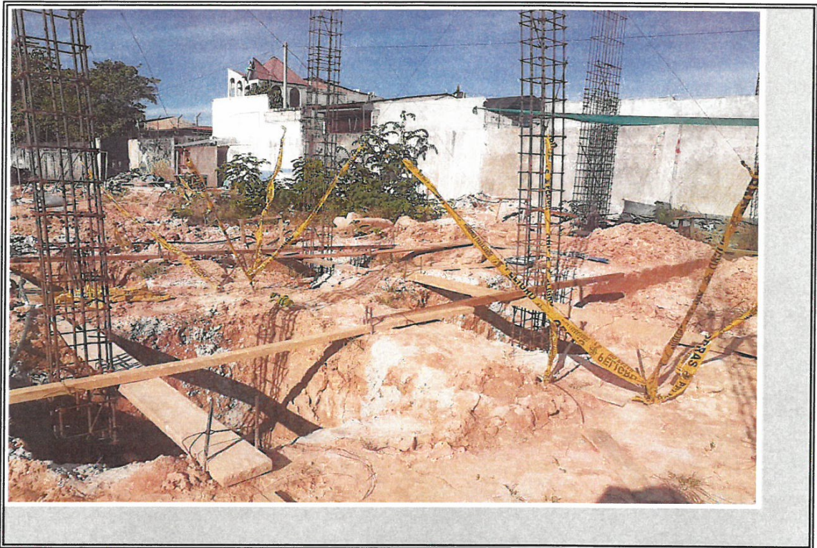
VISTA DE TRABAJOS REALIZADOS EN BLOQUE A
