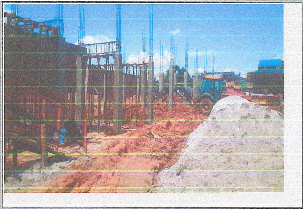
VISTA DE ENCOFRADOS DE FONDO DE VIGAS MOD B
