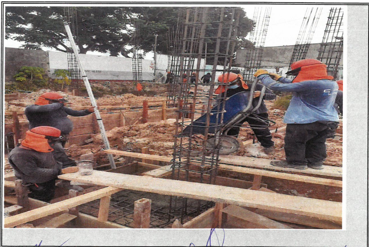
VISTA DE VACIADO DE MORTERO DE ZAPATAS DE MODULO "B"
