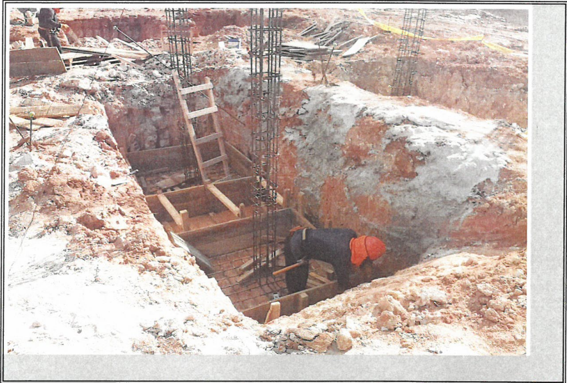
VISTA DE ENCOFRADO ZAPATAS DE MODULO D
