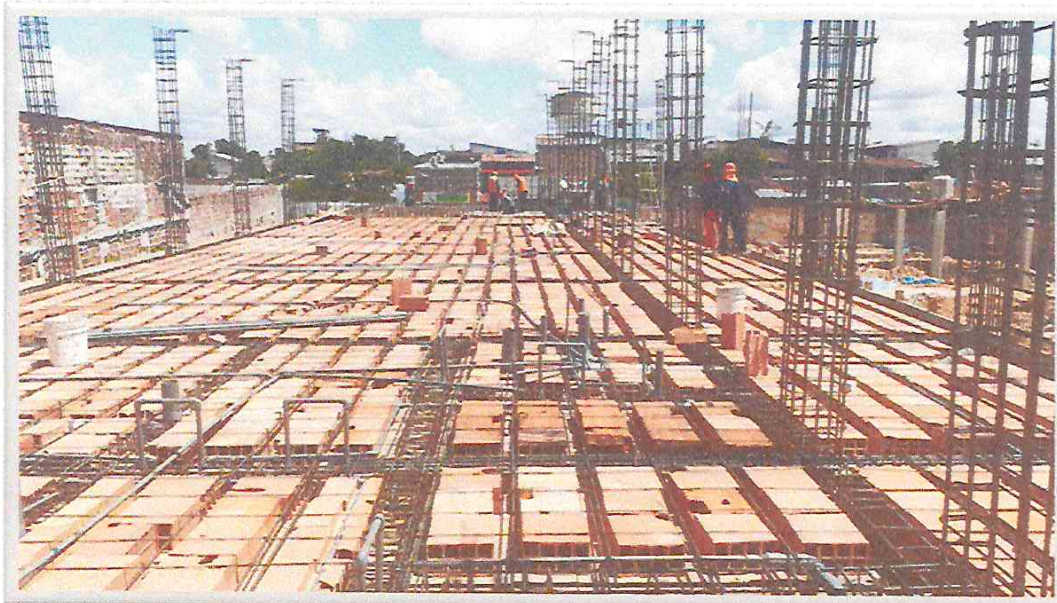
VISTA DE TRABAJOS DE LOSA ALIGERADA DE 2° PISO DE MOD "E"
