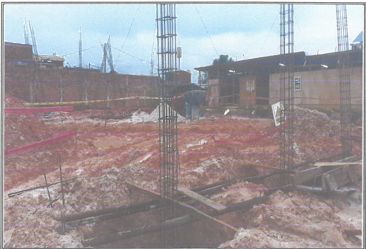
COLOCACION DE ACERO EN COLUMNAS EN EL MÓDULO DE BUBUCO BESA CONSTRUCTORES S.A.C.
