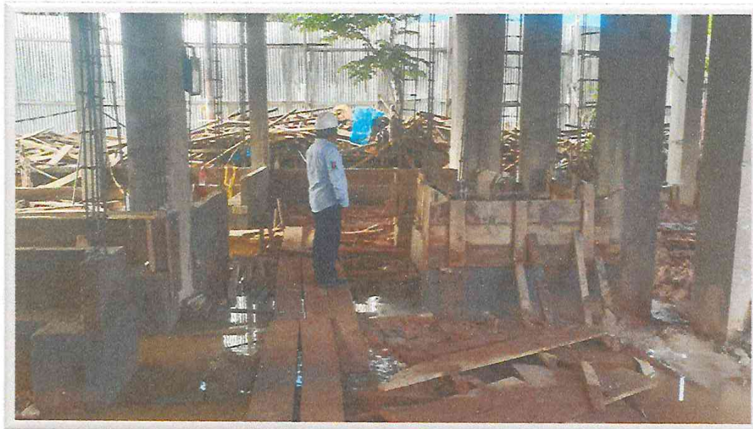
VISTA DE ING RESIDENTE EN CIMENTACION CORRIDO EN MOD "A".
