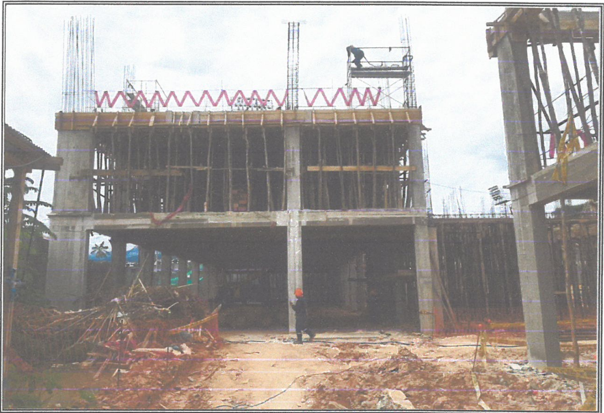
VISTA DE ENCOFRADO DE LOSA ALIGERADA EN EL MODULO A
