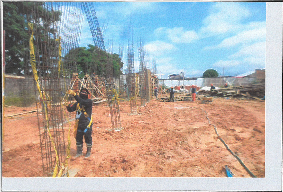
VISTA GENERAL DE TRABAJOS DE BLOQUE B
