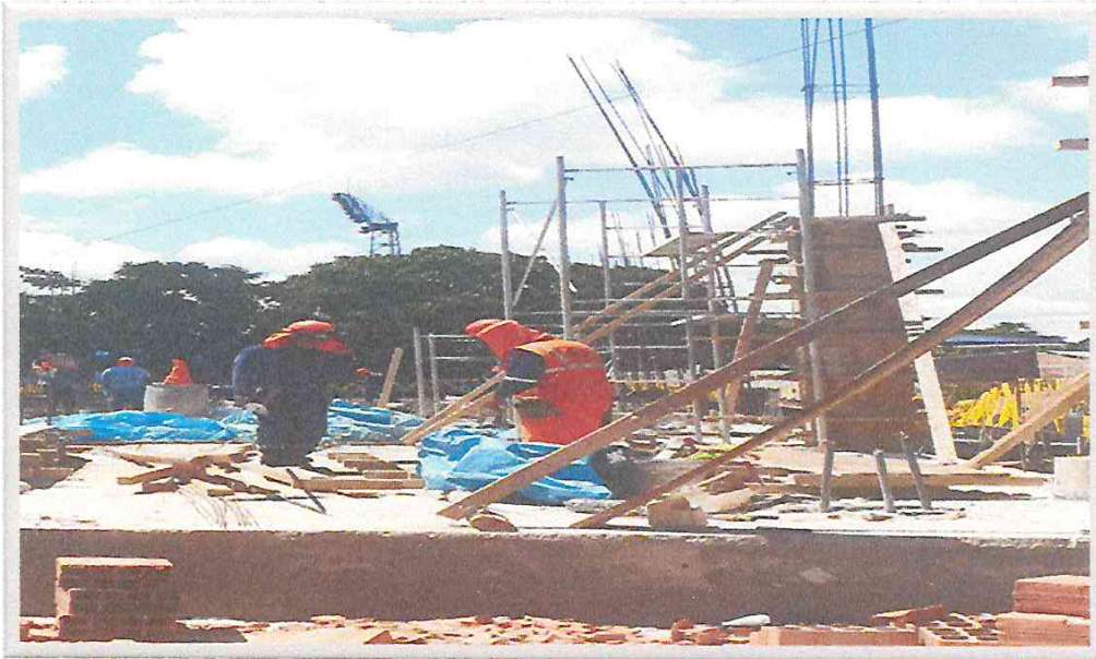
VISTA DE ENCOFRADOS DE MADERA DE COLUMNAS DE 2° PISO DE MOD "1"
