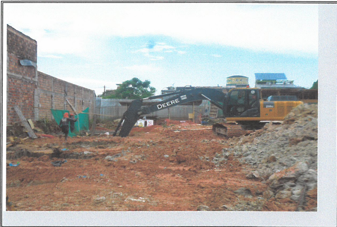
VISTA DE TRABAJOS DE EXCAVACION DE BLOQUE E
