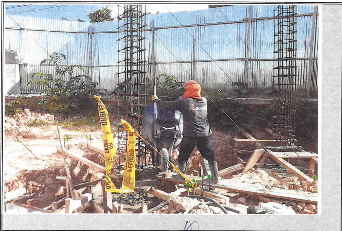
VISTA DE VACIADO DE MORTERO EN ZAPATAS DE BLOQUE A
