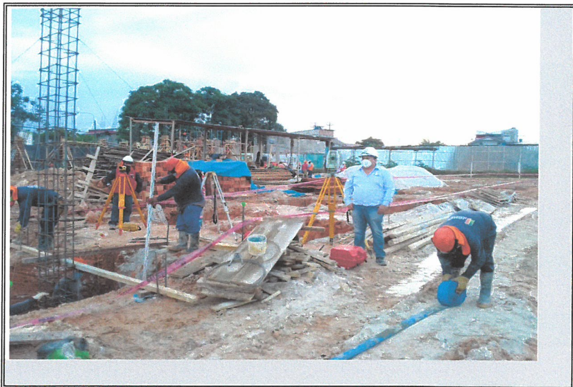
VISTA DE RESIDENTE BLOQUE C
