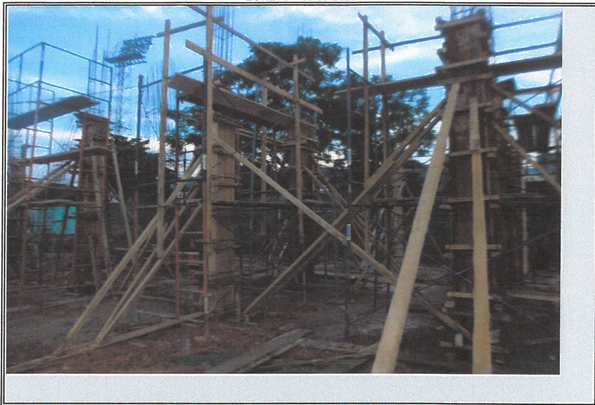
VISTA DE COLUMNAS DE
