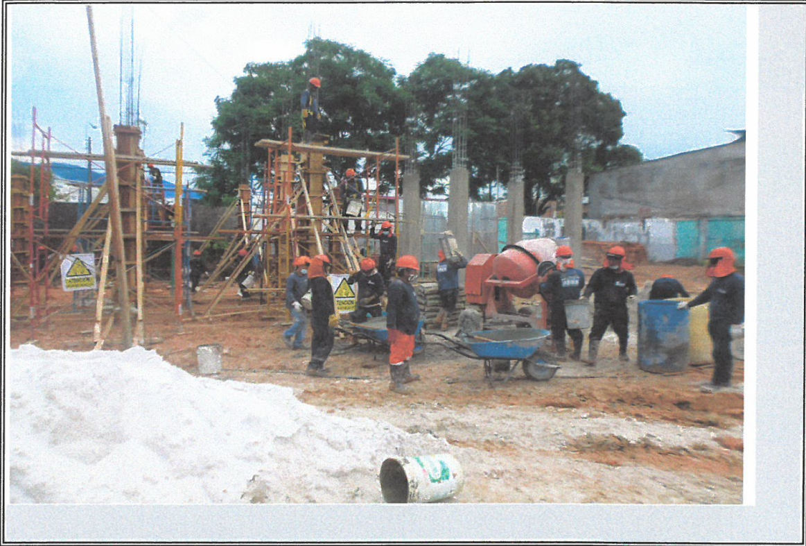
VISTA DE VACIADO DE MORTERO DE COLUMNAS DE BLOQUE B
