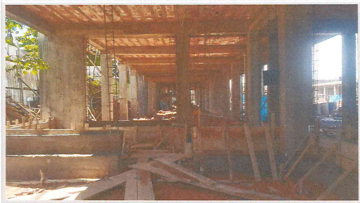
VISTA DE TRABAJOS DE CIMIENTO CORRIDO Y SOBRECIMINETO DE MORTERO SIMPLE EN MOD "A"
