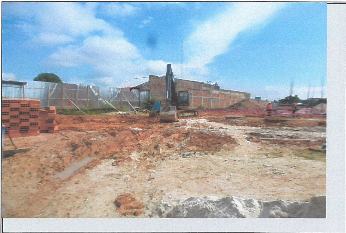
VISTA DE TRABAJOS DE EXCAVACION BLOQUE I GRUPO JOHESA CONSTRUCTORES S.A.C. SAUL YANGARI CARTOLIN GERENTE GENERAL
