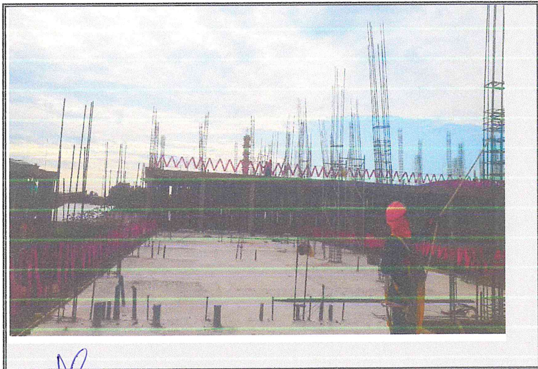
VISTA DE LOSA ALIGERADA MOD C
