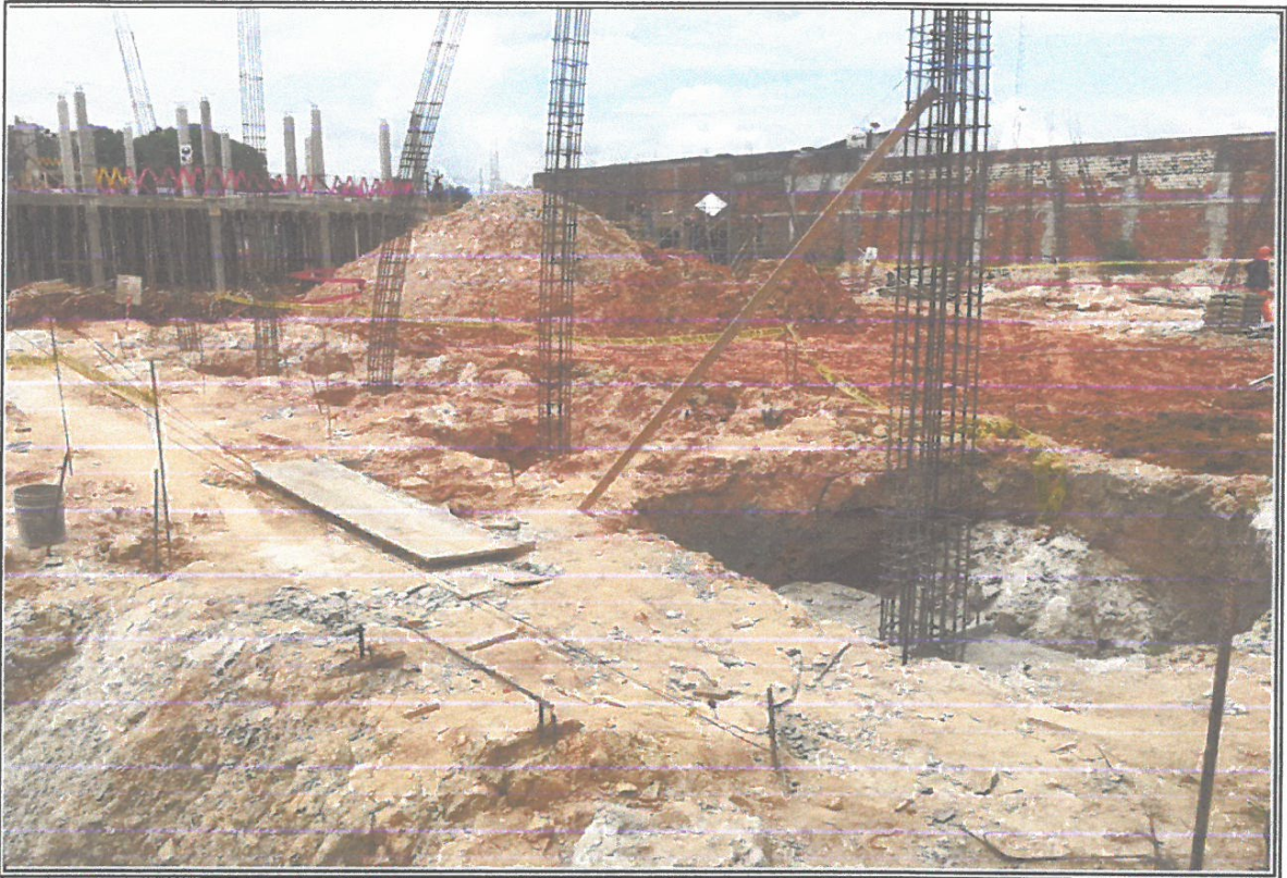
VISTA DE COLOCACION DE ACERO EN COLUMNAS DEL MODULO G
