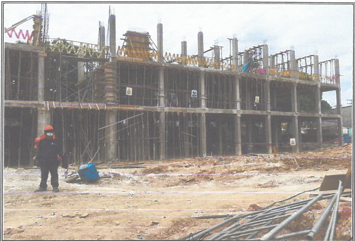
VISTA DE ENCOFRADO DE LOSA ALIGERADA EN EL MODULO A
