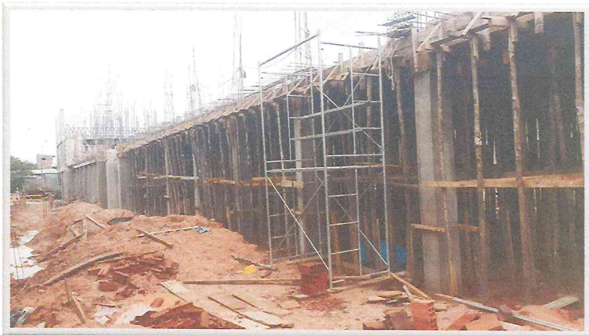
VISTA DE LOSA ALICATADA DE 1° PISO DE MOD "C"
