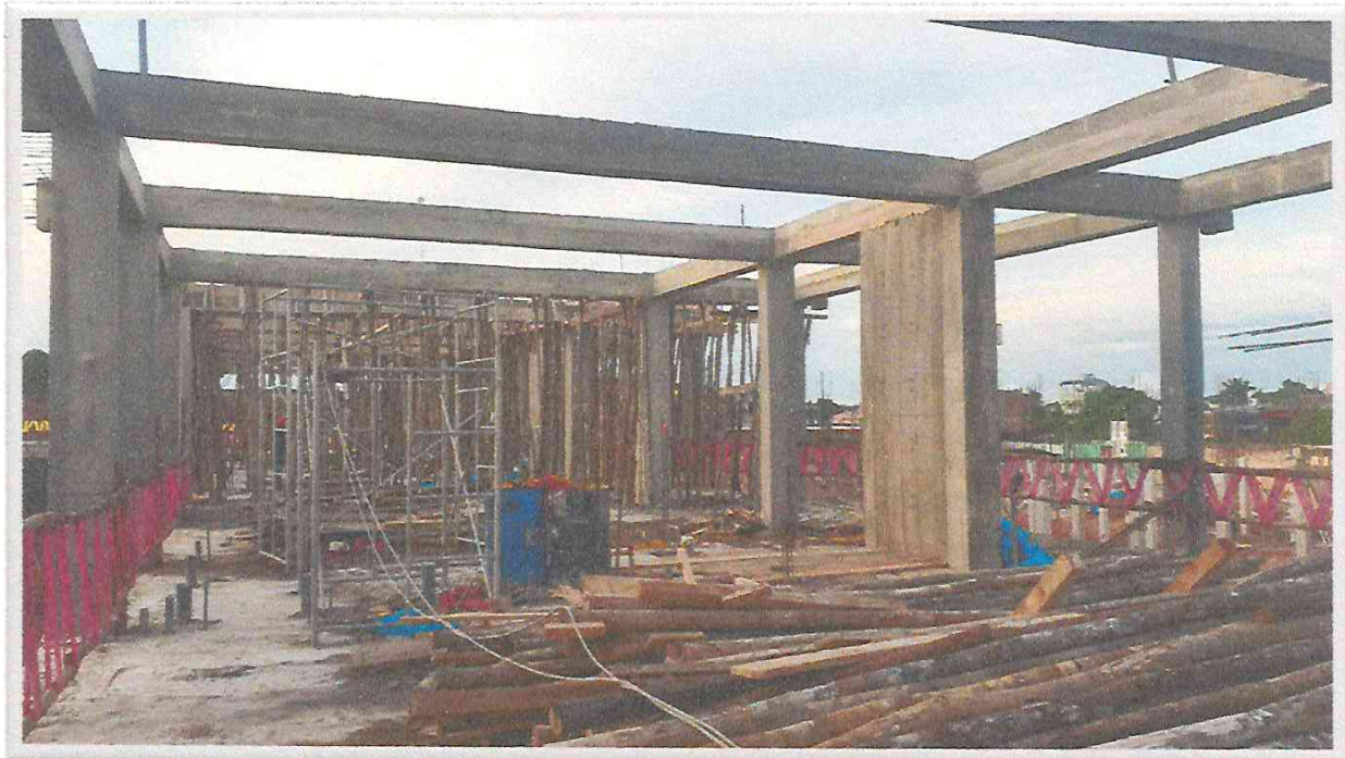
VISTA DE TRABAJOS DE DEENCOFRADO DE MADERA DE VIGAS DE 2° PISO DE MOD "D".
