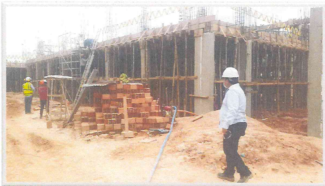
VISTA DE INSPECCION ING RESIDENTE EN MOD "D"
