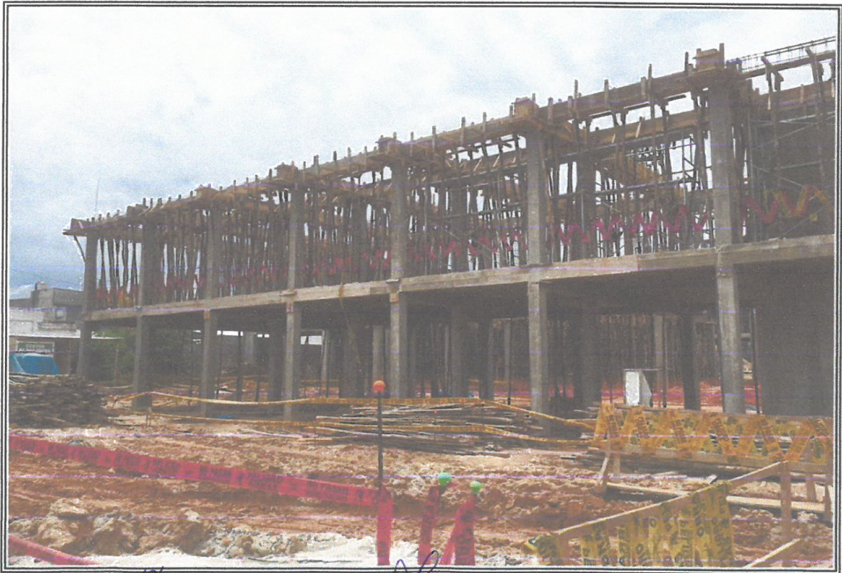
VISTA DE COLOCACION DE ACERO EN COLUMNAS DEL MODULO G
