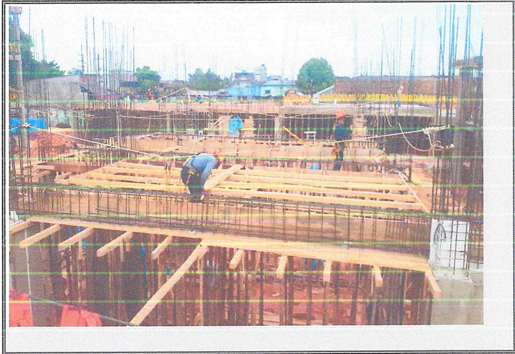
VISTA DE ENCOFRADO DE LOSA ALIGERADA DE MOD C
