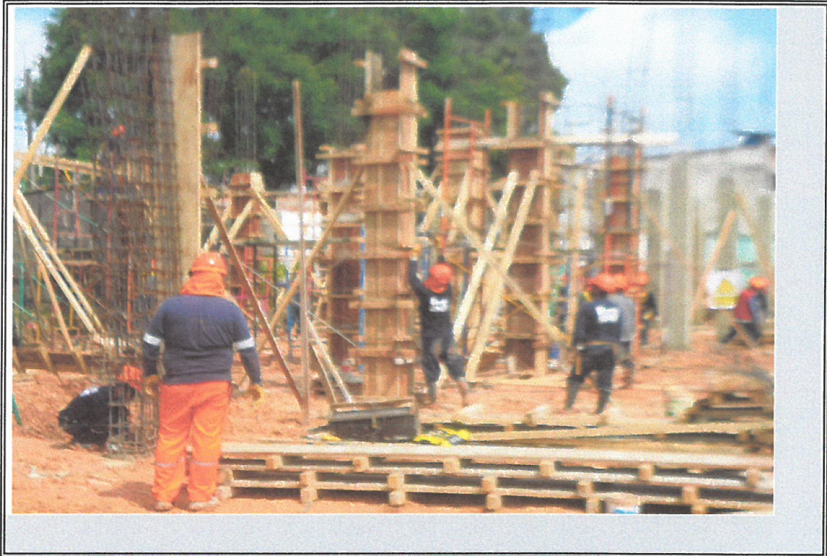
VISA DE ENCOFRADO DE MADERA DE ZAPATAS EN MODULO C
