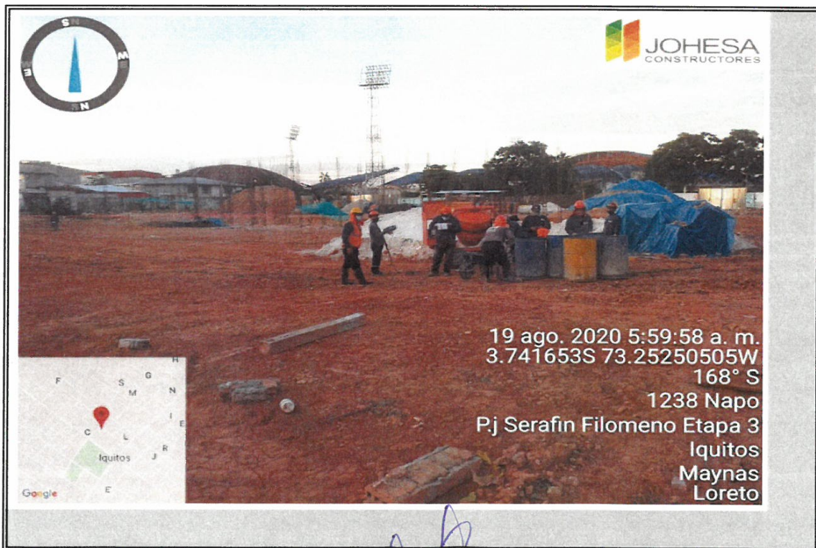
GRUPO JOHESA CONSTRUCTORES S.A.C. VISTA DE VACEADO DE TANQUE CISTERNA
