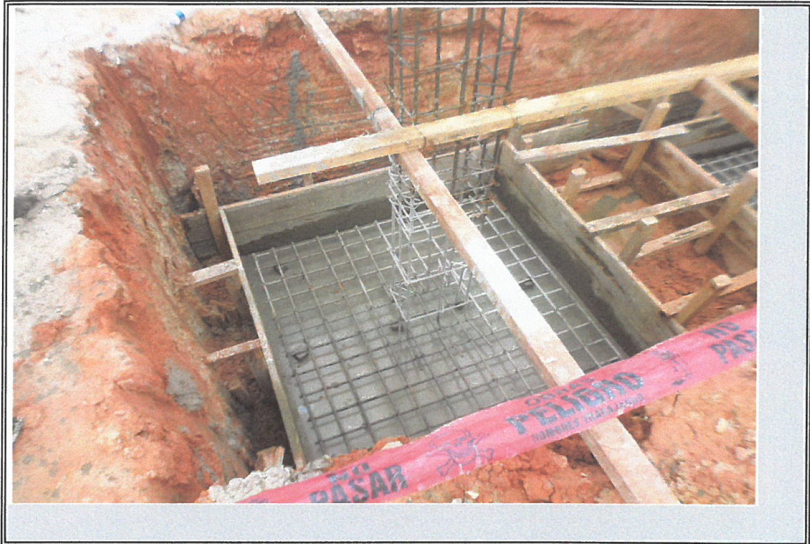
VISTA DE ZAPATA Y COLUMNAS DE ACERO EN BLOQUE D
