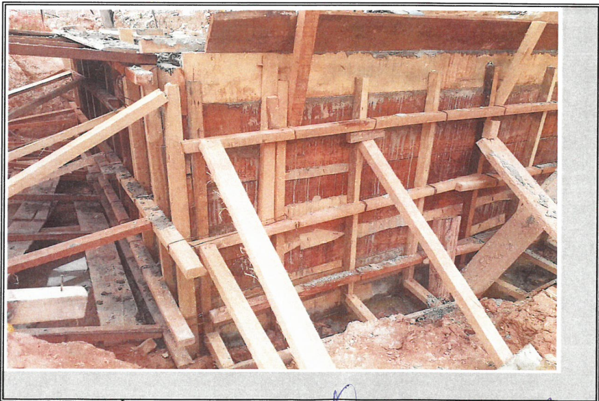
VISTA DE ENCOFRADO DE MADERA DE TANQUE CISTERNA
