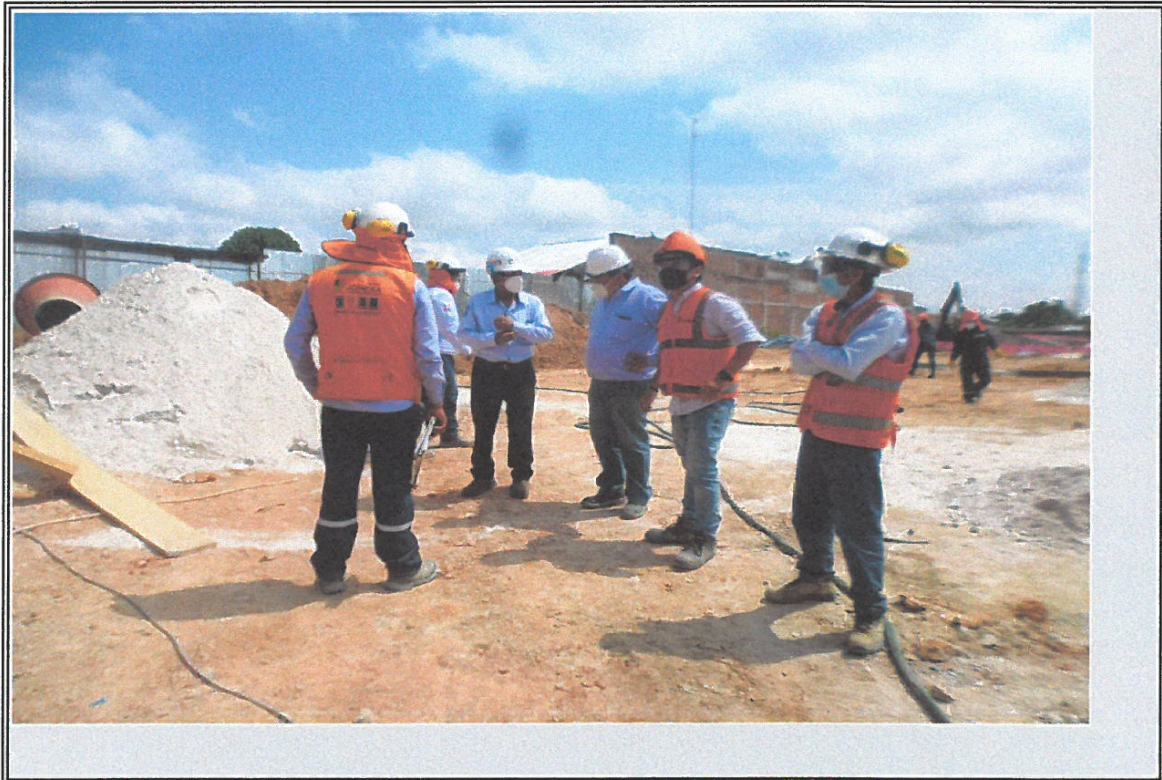
VISTA SUPERVISION Y RESIDENTE EN TRABAJOS EN BLOQUE B
